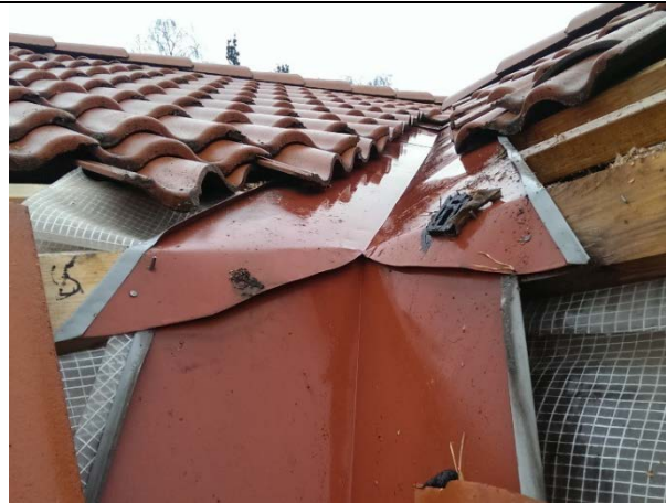
Plåtarbete som medfört skada på ett monteringsfärdigt hus. Foto: Gar-Bo.
