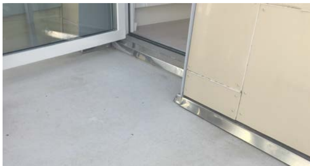
Flerfamiljshus under uppförande. Här har skydd mot inträngande vatten prioriterats. Tydlig nivåskillnad mellan bjälklag inne och ute, balkongbjälklag med fall utåt, dubbla plätningar för att ge tvåstegstätning. Foto: Oden & Oden AB.
