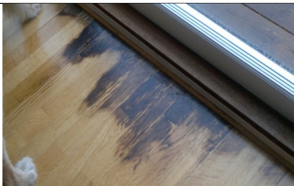
Skada i villa av vatten som trängt in under tröskel. Foto: Gar-Bo.
