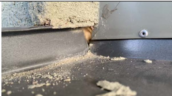
Nybyggt flerfamiljshus med bristfälligt utförda plåtarbeten. Drevet under fönstret är blött. Foto: Oden & Oden AB.
