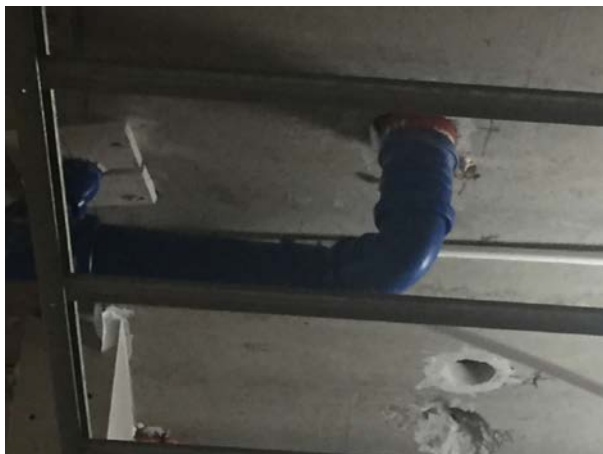
Avlopp med felaktigt fall och med bristfällig upphängning. Foto: Oden & Oden AB.
