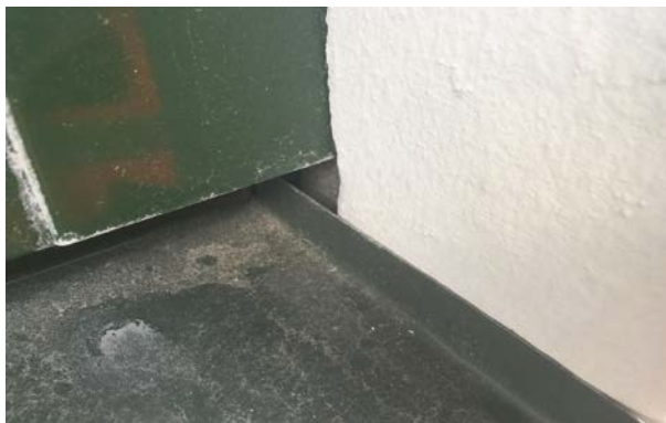
Flerfamiljshus där felaktigt projekterad plåtning medfört inträngande vatten och en omfattande skada. Foto: Oden & Oden AB.
