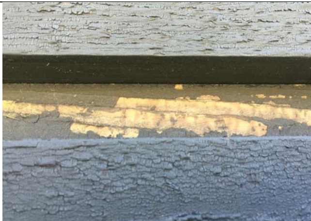
Specialbeställd panel monterad på en villa. Slamfärg flagar på hyvlade ytor och panelens djupa horisontella ytor har medfört röta. Foto: Oden & Oden AB.
